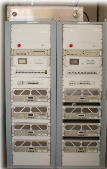
Figure 3 deux Amplificateurs associés pour obtenir 20KW
